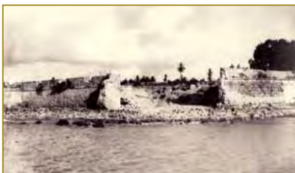
O estado de abandono em que chegaram a ficar as muralhas
