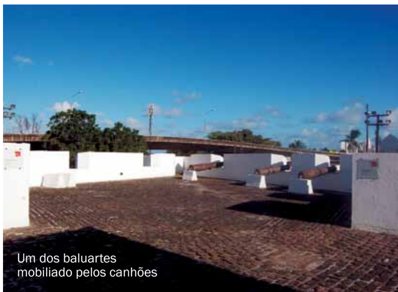
Pátio interno. Ao fundo as instalações do Cmt e o xadrez
