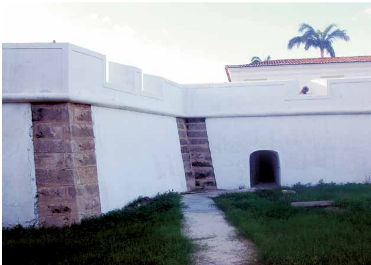
Acima, muralha externa e saída do túnel de fuga
